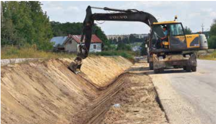
Profilowanie rowów na etapie nr 1 obwodnicy, od ul. Kościuszki do ul. Krakowskiej.
