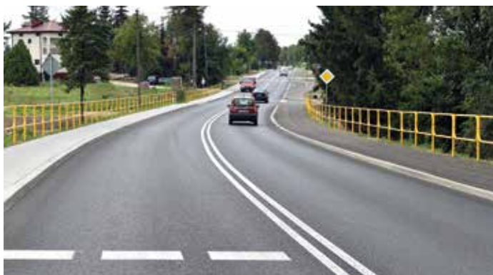
Fragment wyremontowanej drogi wojewódzkiej 757 Staszów-Sielec, o długości 3,2 km i wartości 4 mln 138 tys. zł. Inwestycja została oddana do użytku w końcu sierpnia br.
