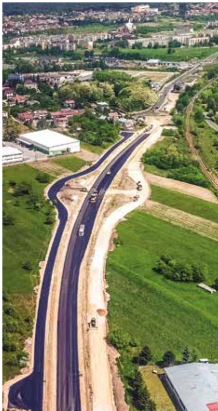
Odcinek etapu I obwodnicy Staszowa od ul. Kościuszki do ul. Krakowskiej, z drogami serwisowymi.
