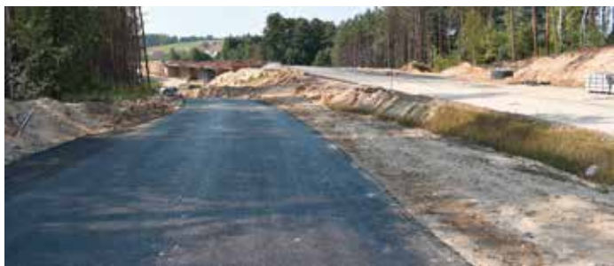
Odcinek etapu IV, widok w kierunku mostu, z lewej: droga serwisowa.
