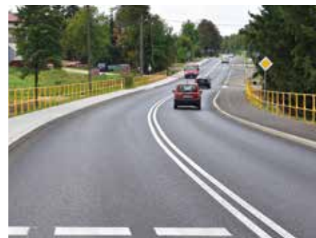
Jeden z odcinków odbudowanej drogi wojewódzkiej 757, od Staszowa do Sielca.
