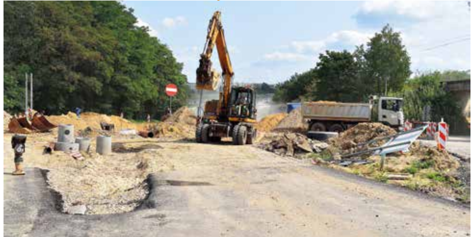
Prace przy budowie ronda nr 1 na ul. Kościuszki, będą prowadzone przez najbliższe 3 tygodnie.
