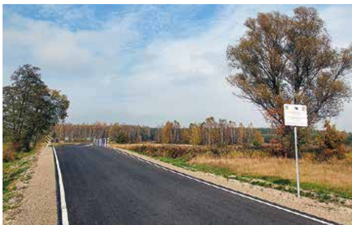
Wyremontowana droga powiatowa w Brodach, gmina Oleśnica. Ogółem, w minionej kadencji 2014 - 2018 wyremontowano łącznie 82,5 km dróg powiatowych za kwotę 26 mln 200 tys. zł, z czego 15 mln 900 tys. zł, tj. 61% pochodziło z funduszy unijnych oraz z programów krajowych.
