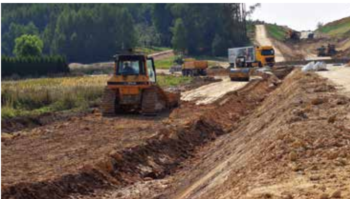
Na odcinku II A, od ul. Oględowskiej do mostu na rzece Czarnej budowana jest droga serwisowa.
