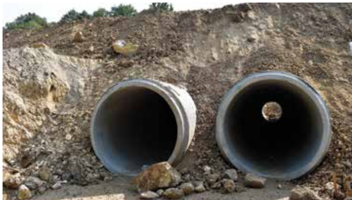
Na odcinku etapu II A, położono 2 rzędy, w sumie 28 kręgów o przekroju 2 m, w celu odprowadzenia większej wody, w razie jej wystąpienia.
