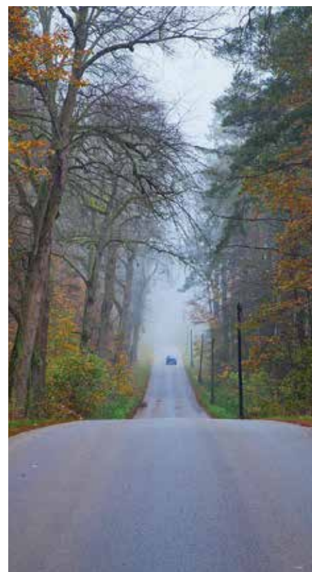
Nowa nawierzchnia drogi powiatowej Kurozwęki – Czernica.
