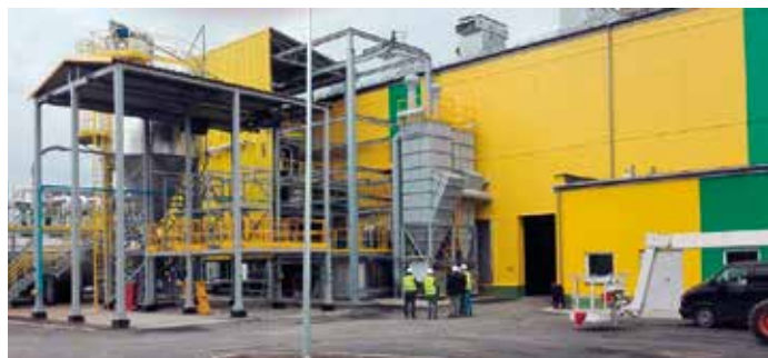
Fragment Linii Demonstracyjnej na Wydziale Granulacji i Mielenia Siarki w Zakładach Chemicznych „Siarkopol” Tarnobrzeg, inwestycji jaką INTESTER Sp. z o.o. ukończył w maju br.
