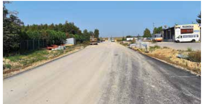
Odcinek etapu II obwodnicy, od ul. Krakowskiej w kierunku ul. Oględowskiej.
