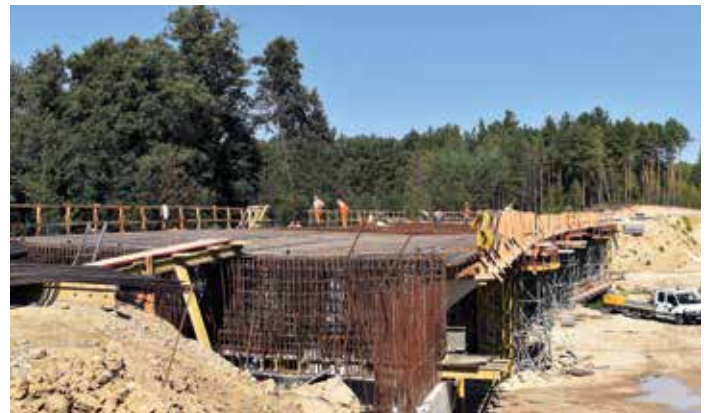
Budowa szalunków i zbrojeń pod zalanie betonem konstrukcji mostu w celu połączenia belek mostowych i obydwu przyczółków.
