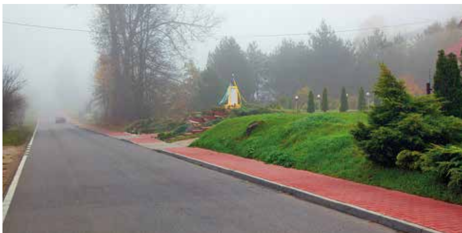
Odbudowana nawierzchni drogi powiatowej w Sztombergach, z nowym chodnikiem.
