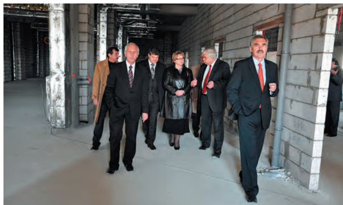
Podczas zwiedzania budowy Bloku Operacyjnego, starostowie powiatu i delegacja GDF SUEZ Energia Polska S.A.
