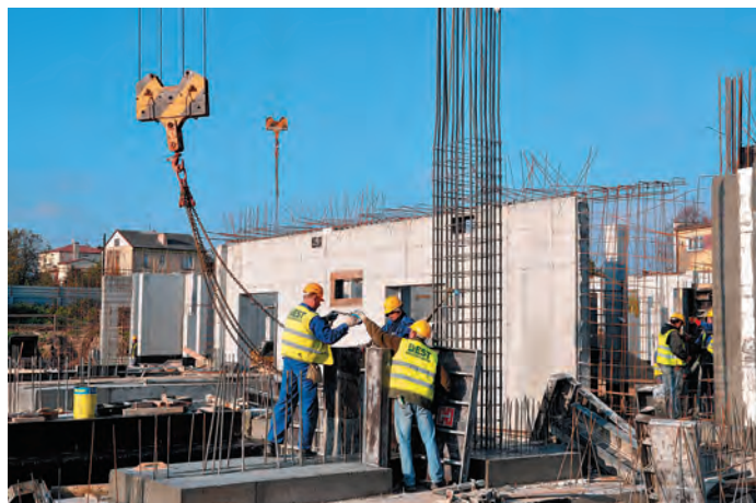
Inwestycję realizuje BEST Construction Sp. z o.o. z Rzeszowa.
