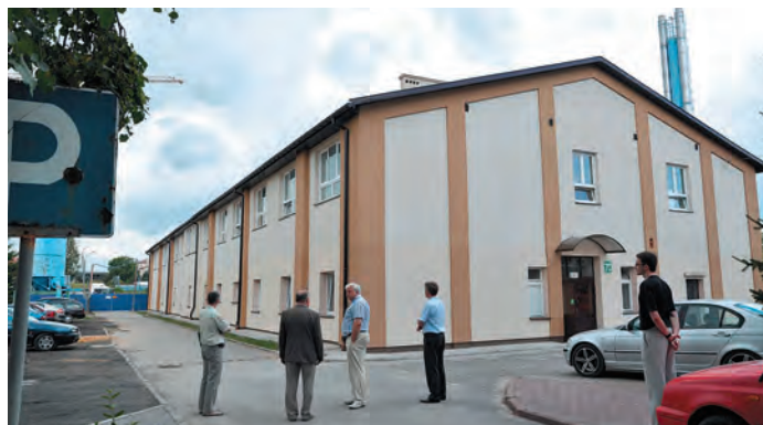
Rozbudowany budynek dawnej pracowni stolarskiej, od strony wschodniej.
