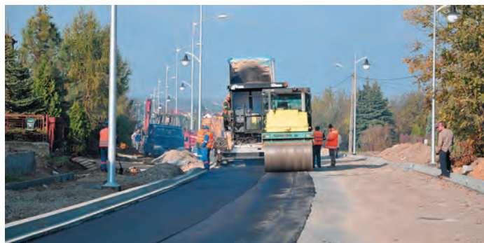
Położenie nowej nawierzchni na ul. 11 Listopada w Staszowie, w dniu 6 października 2010 r.
