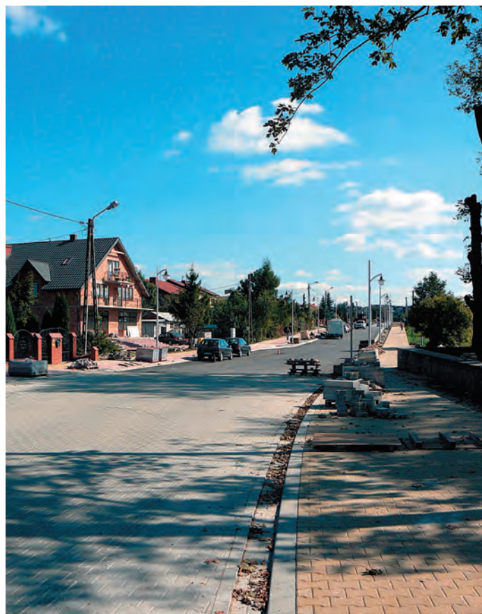
Przebudowa ul. 11-go Listopada w Staszowie.
