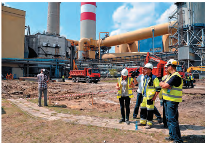
W tym miejscu niebawem rozpocznie się budowa największego w świecie bloku energetycznego opalanego wyłącznie biomasą, o mocy 190 MW.
