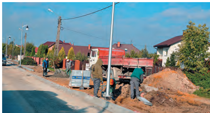
Przebudowa ul. 11 Listopada w Staszowie, stan prac w dniu 6 października 2010 r.
