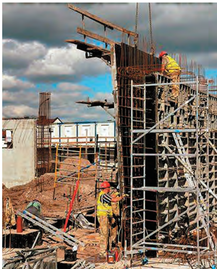
Powiatowe Centrum Sportowe w budowie.
