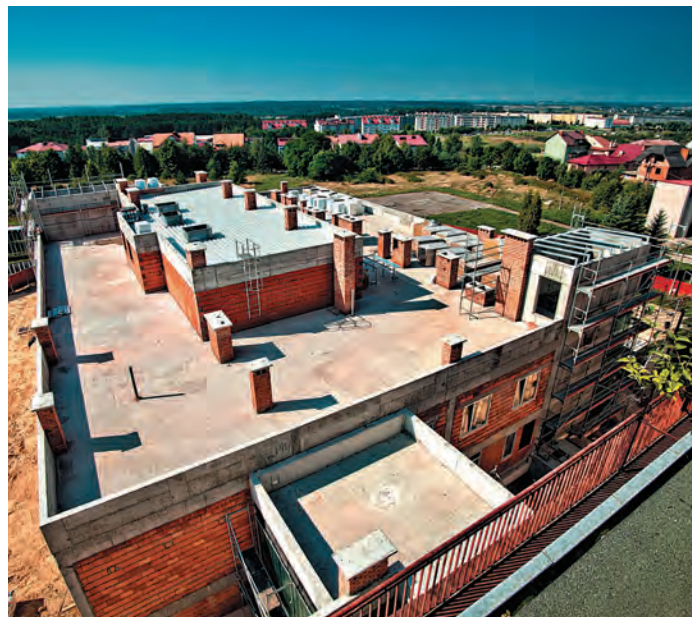
Szpital w Staszowie, budowa bloku operacyjnego.
