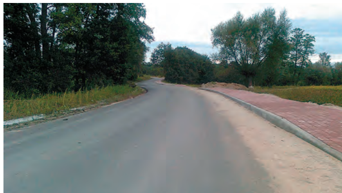
Odbudowana po powodzi droga powiatowa Połaniec – Rybitwy.
