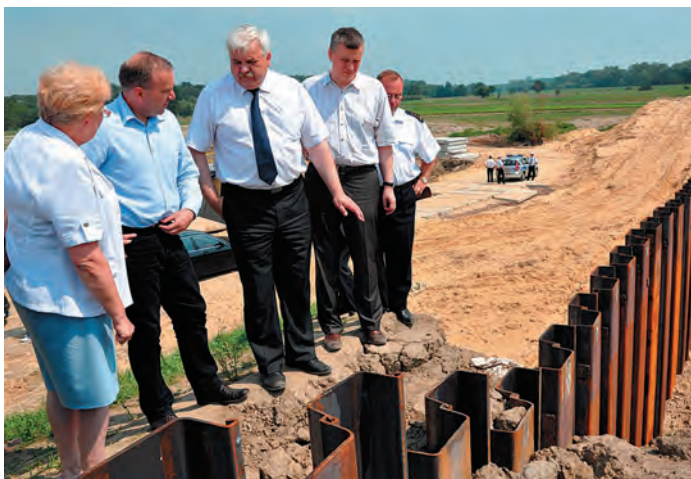
Wizyta na uszkodzonych wałach. O przebiegu realizacji zabudowy wyrwy w wałe wiślanym w Rybitwach, marszałka Grzegorza Schetynę poinformował starosta staszowski Romuald Garczewski.
