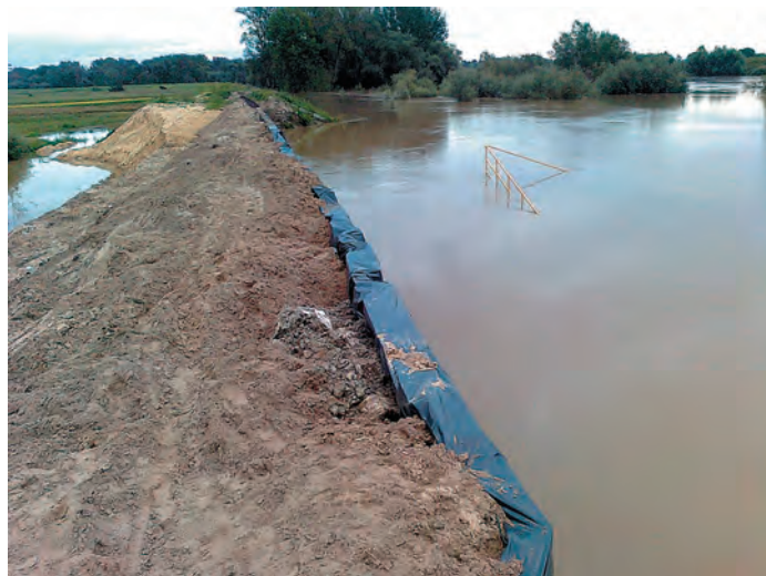
Zabezpieczenie wyrwy w Rybitwach „larsenami” wytrzymuje napór fali powodziowej na Wiśle, sobota, 4 września br., godz. 18 00 , stan wody wynosił wtedy 720 cm i był większy o 50 cm od stanu alarmowego.
