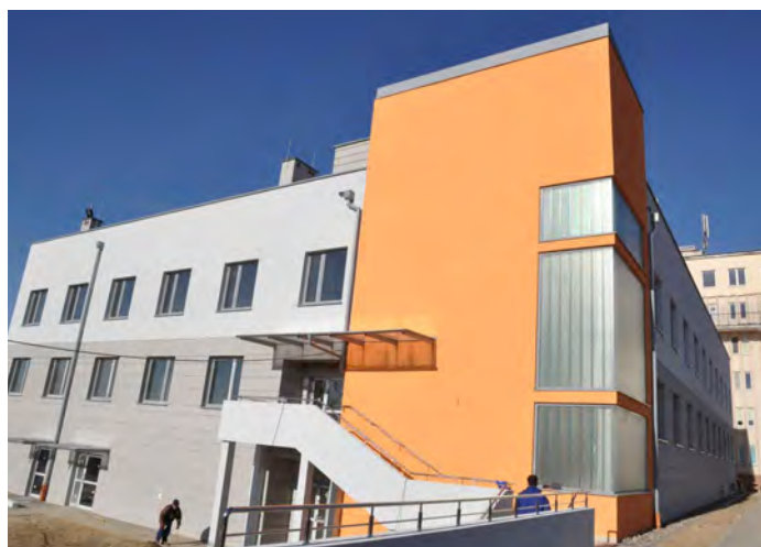
Blok operacyjny staszowskiego szpitala od strony południowo-wschodniej, stan w dniu 10 lutego 2011 roku.
