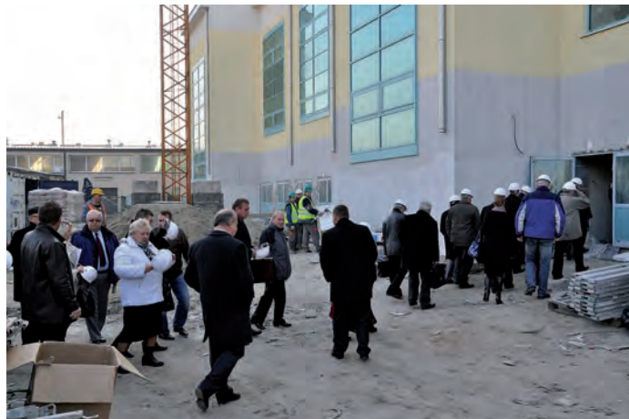
Po zakończeniu obrad, radni i zaproszeni goście zapoznali się z realizacją budowy Powiatowego Centrum Sportowego, po którym oprowadzał kierownik budowy Tomasz Polek.
