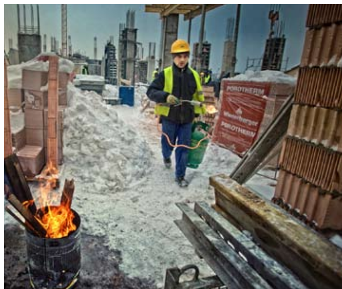
Prace na budowie Powiatowego Centrum Sportowego.
