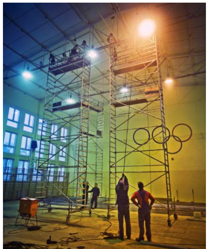
Prace trwają wewnątrz hali, wzmacnianie konstrukcji dachu.
