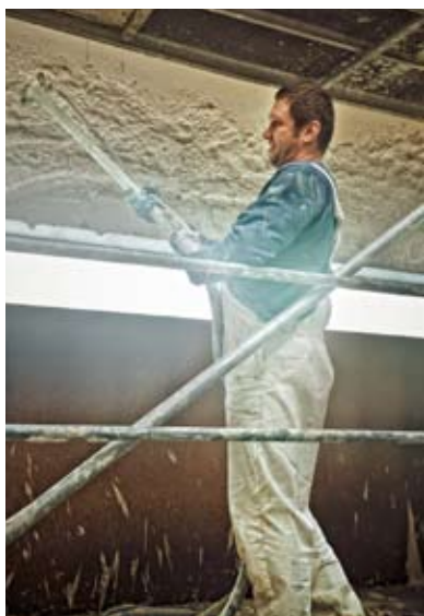
Trwa tynkowanie klatki schodowej.
