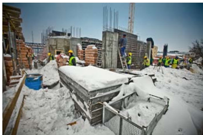
Wykonanie konstrukcji piętra.
