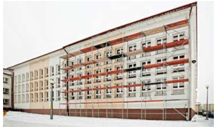
Rusztowania przy hali sportowej staszowskiego LO, od strony wschodniej.
