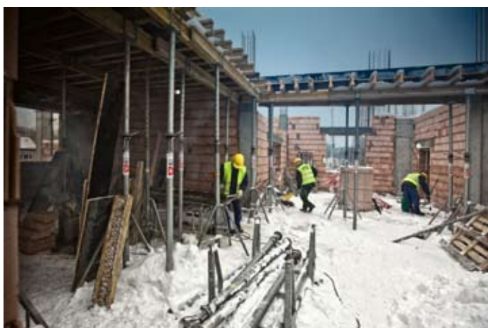
Konstrukcja piętra cd.
