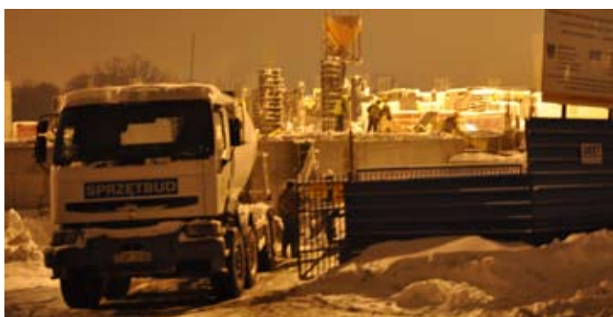
Mimo zimy prowadzone są prace betoniarskie.
