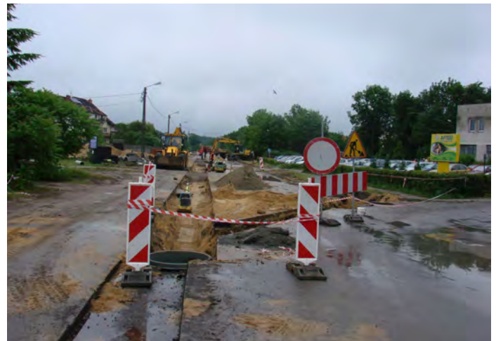
Przebudowa ul. 11 Listopada w Staszowie.
