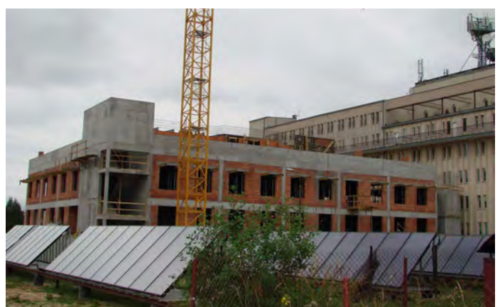
...rosną mury bloku operacyjnego w szpitalu, stan prac w dniu 21 czerwca 2010 r.
