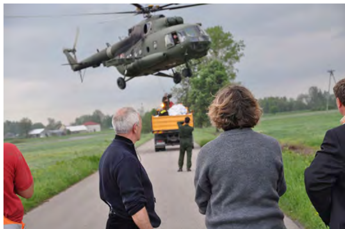
W Rejterówce, transport półtoratonowych worków, jedynie drogą powietrzną.
