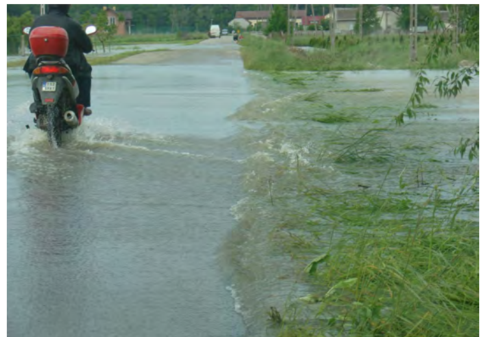
Zalewana droga nr 0822T Ruszcza – Słupiec – Tarnowce.
