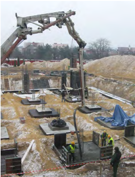
Prace betoniarskie, pierwsza dekada marca br.
