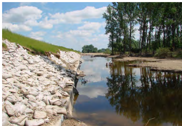
Rozmycie wału nastąpiło na długości ponad 250 m.
