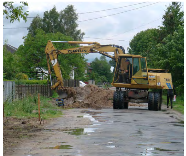
Przebudowa drogi nr 0790T Smerdyna – Grobla.
