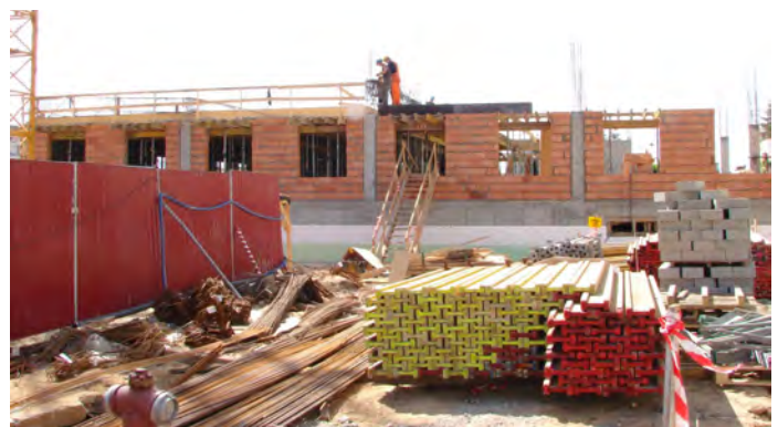
Rozbudowa staszowskiego szpitala – budowa bloku operacyjnego, stan surowy, stan na 5 maja 2010 roku.
