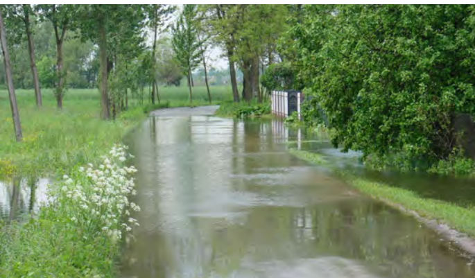
Podtopiona droga nr 8822T Ruszcza - Słupiec – Tarnowce.
