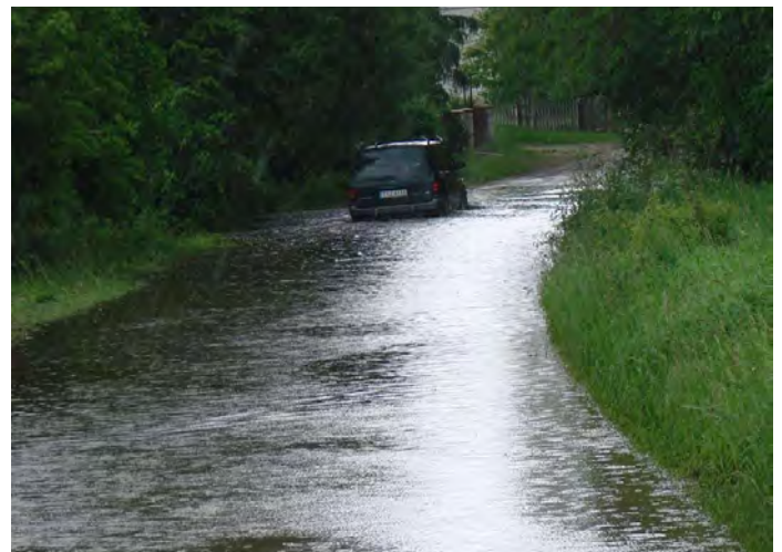
Podtopiona droga pow. nr 0811T Osiek – Lipnik, w m. Lipnik.
