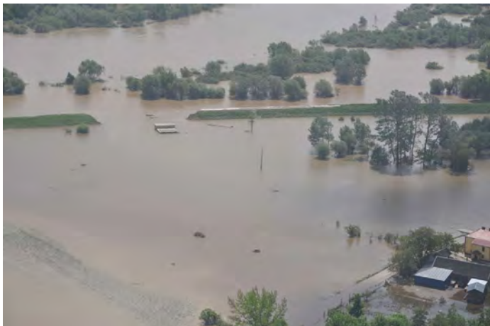
Uszkodzony wał wiślany w Rybitwach przy przepompowni.
