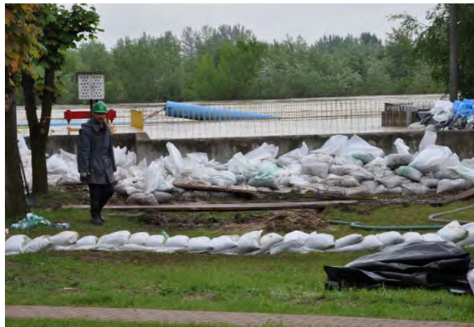
Środa 19 maja br., w Elektrowni GDF SUEZ, przy kanale spustowym.
