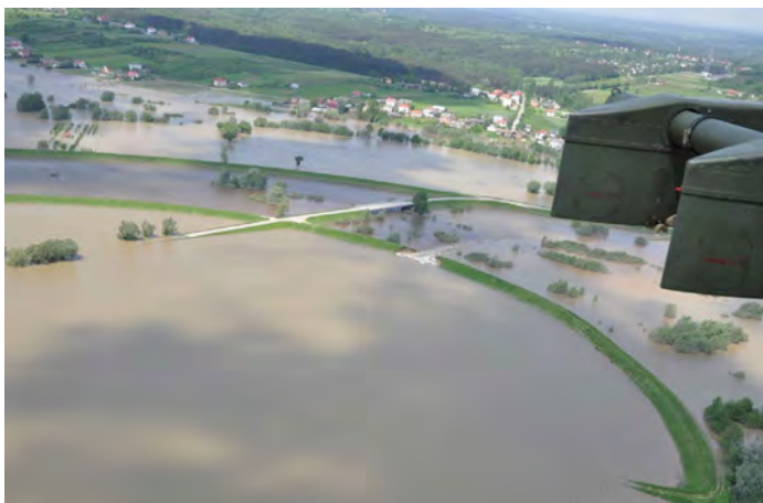
Rozkopany wał w Ruszczy Kępie, w celu spuszczenia wody do Wisły.
