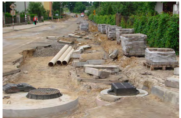
Ul. Langiewicza, budowa kanalizacji: prace instalatorskie: elektryczne i gazownicze.
