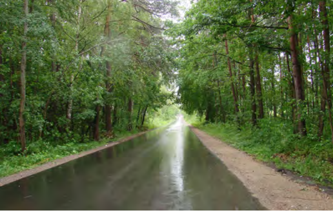
Przebudowa drogi nr 0813T Wiśniówka - Niekrasów.
