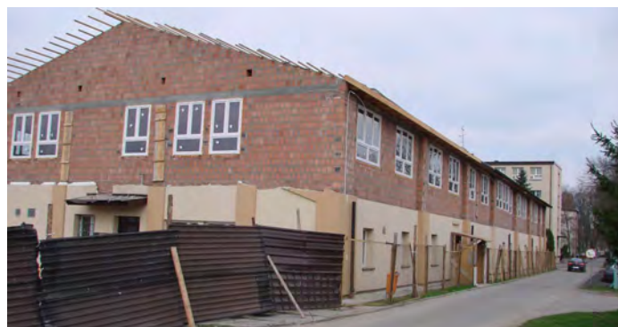
Nadbudowa piętra nad warsztatami stolarni, zaawansowanie robót w dniu 8 kwietnia br.
