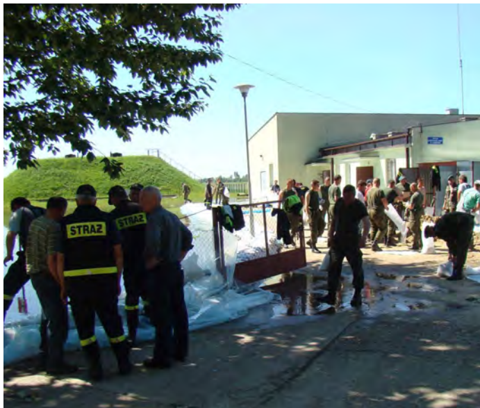
Sobota, 5 czerwca, br., w południe. Umacnianie obwałowania ujęcia wody w Łubnicach, pracując druhowie OSP z terenu gminy i żołnierze Batalionu Łączności z Sieradza.
