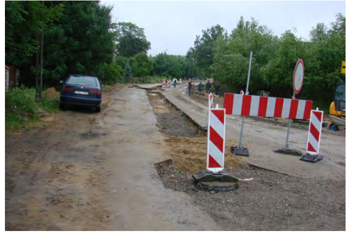
Przebudowa ul. Langiewicza i 11 Listopada w Staszowie.
