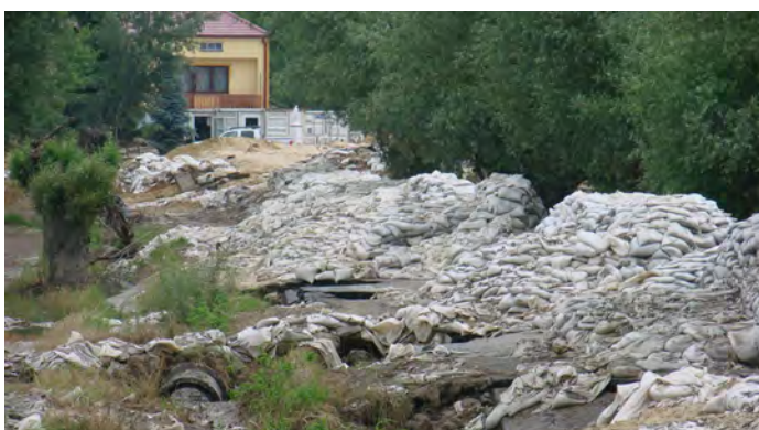
Droga 0820T Połaniec - Budziska w miejscowości Rybitwy, na której zrobiony był wał, zniszczony przez kolejną falę powodziową 4.06.2010 r.
