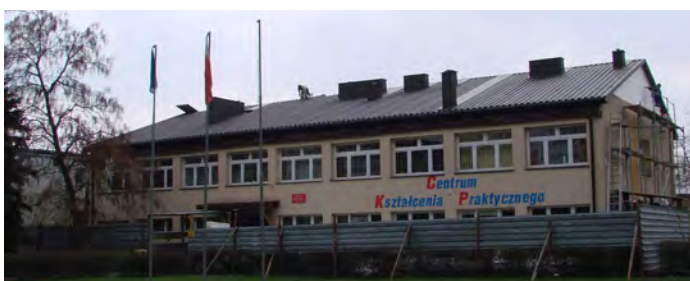
Dach nad Centrum Kształcenia Praktycznego w Staszowie w dniu 8 kwietnia br.
