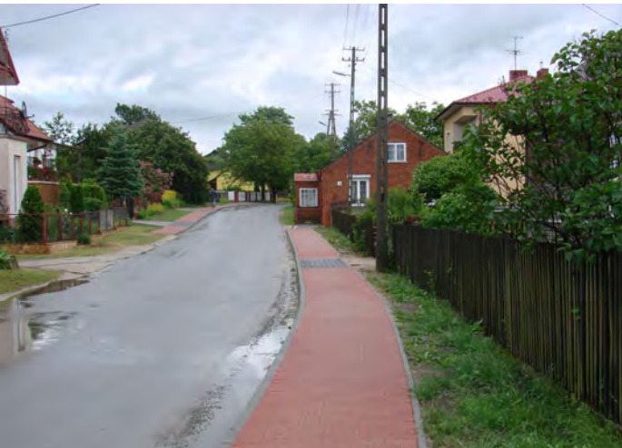
Przebudowa drogi nr 0790T Smerdyna - Grobla.
