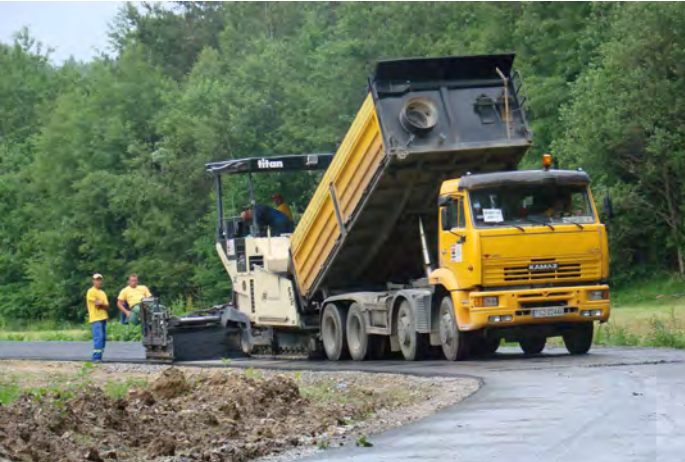
Przebudowa drogi nr 0713T Haliszka - Grzybów.
