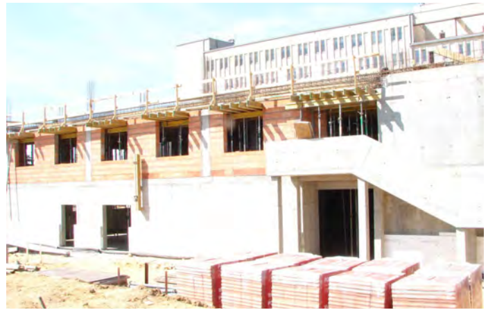
Rozbudowa staszowskiego szpitala – budowa bloku operacyjnego, stan na 5 maja 2010 roku.
