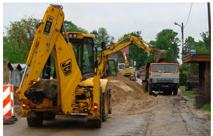
Ul. Langiewicza w przebudowie.
