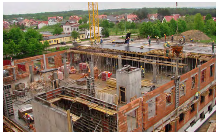
Budowa bloku operacyjnego w SPZZOZ w Staszowie, stan w środę 19 maja br.
