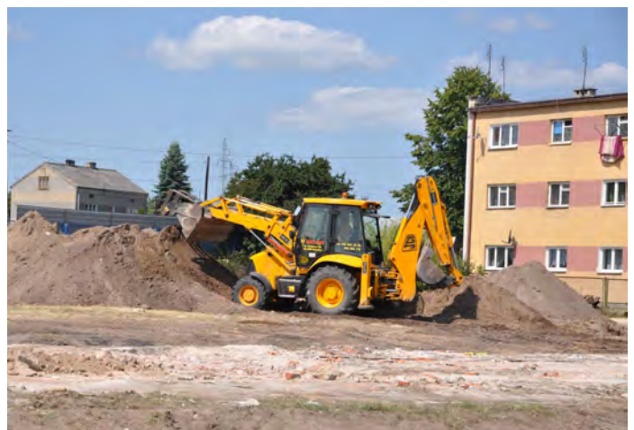
W połowie czerwca br., inwestor rozpoczął grodenie placu i prace przygotowawcze, rozebrano magazyn i rozpoczęto wykopy. Foto z 30.06.2010 r.
