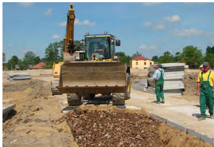
Budowa drogi dojazdowej do uszkodzonego wału w Rybitwach, foto z 18.06.2010 r.
