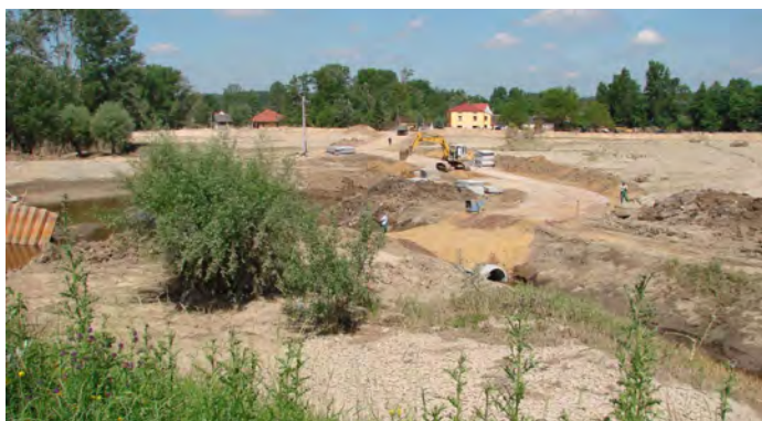
Budowa drogi dojazdowej do przepompowni w Rybitwach, 18.06.2010 r.
