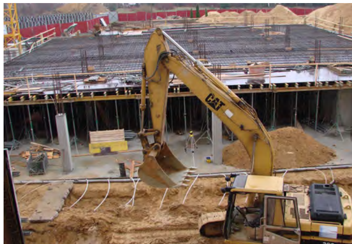
Stan inwestycji na dzień 6 kwietnia br. W bezpośrednim sąsiedztwie budowy - bateria solarów.
