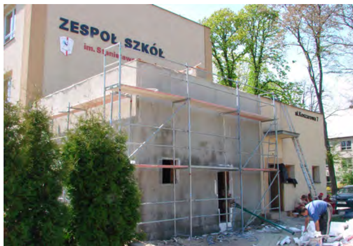
Rozbudowa Internatu Zespołu Szkół przy ul. Koszarowej 7, stan surowy, 5.05.2010 roku.
