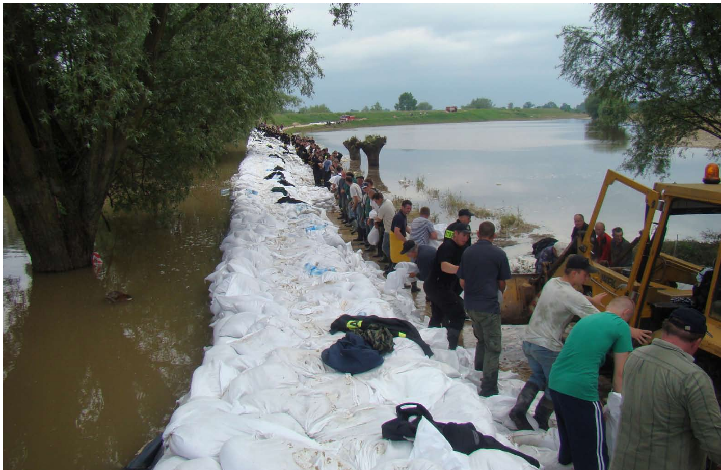
Środa 2.06 i czwartek 3.06, trwają intensywne prace przy budowie opaski - wału z piachu i worków, przy wyrwie na wale wiślanym w Rybitwach.
