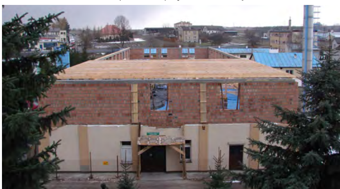
Przebudowa i rozbudowa budynku zajęć praktycznych Zespołu Szkół, polega na dobudowaniu jednego piętra na budynku warsztatów stolarni im. Stanisława Staszica w Staszowie, dla potrzeb dydaktycznych technikum budowlanego, stan prac w dniu 8 marca br.
