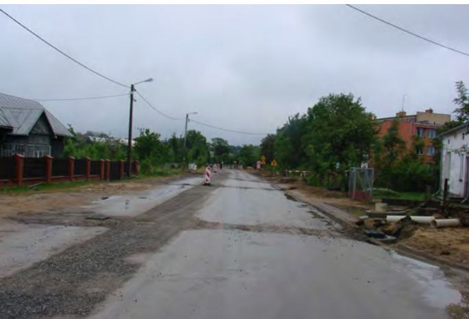
Przebudowa ul. Langiewicza i 11 Listopada w Staszowie.
