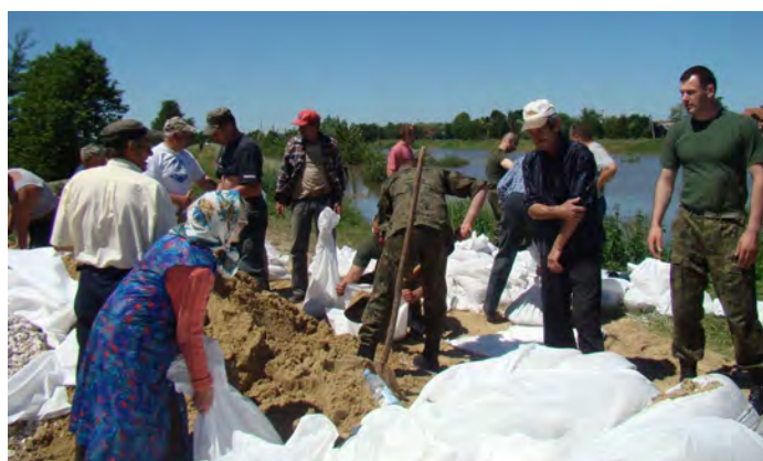
Przy umacnianiu wyrwy pomagają okoliczni mieszkańcy.
