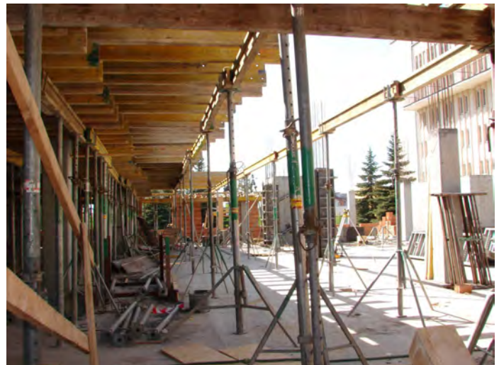
Nowoczesne rusztowania przyspieszają proces budowy, stan na 5 maja 2010 r.
